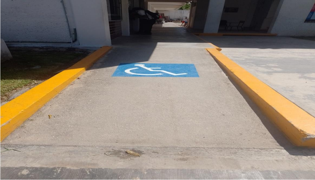
5. RAMPA DEL EDIFICIO RUMBO A OFICINAS
