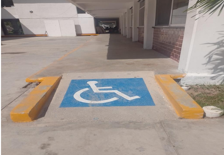
3. RAMPA DEL TERCER EDIFICIO
