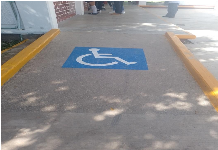
4. RAMPA DEL EDIFICIO DE LA BIBLIOTECA
