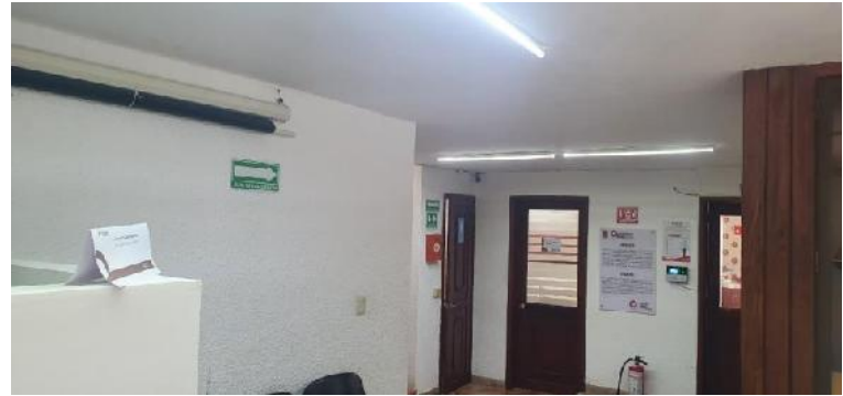
SEÑAL DE RUTA DE EVACUACION DE AREA DE CUBICULOS
