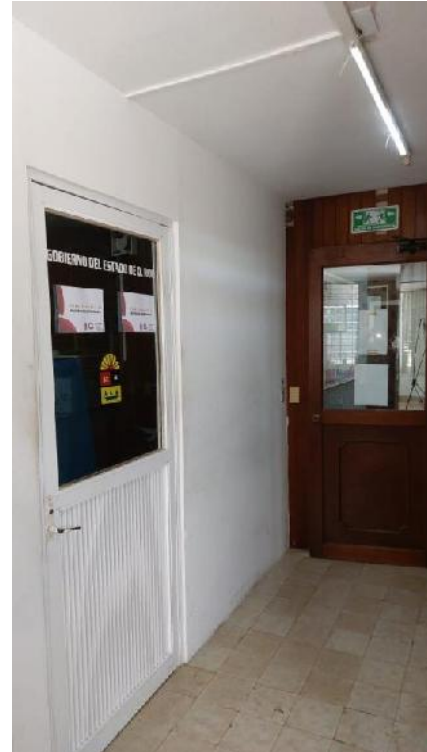
SALIDA DE EMERGENCIA DEL PASILLO HACIA EL VESTIBULO Y PUERTA DE DEPARTAMENTO DE RECURSOS MATERIALES
