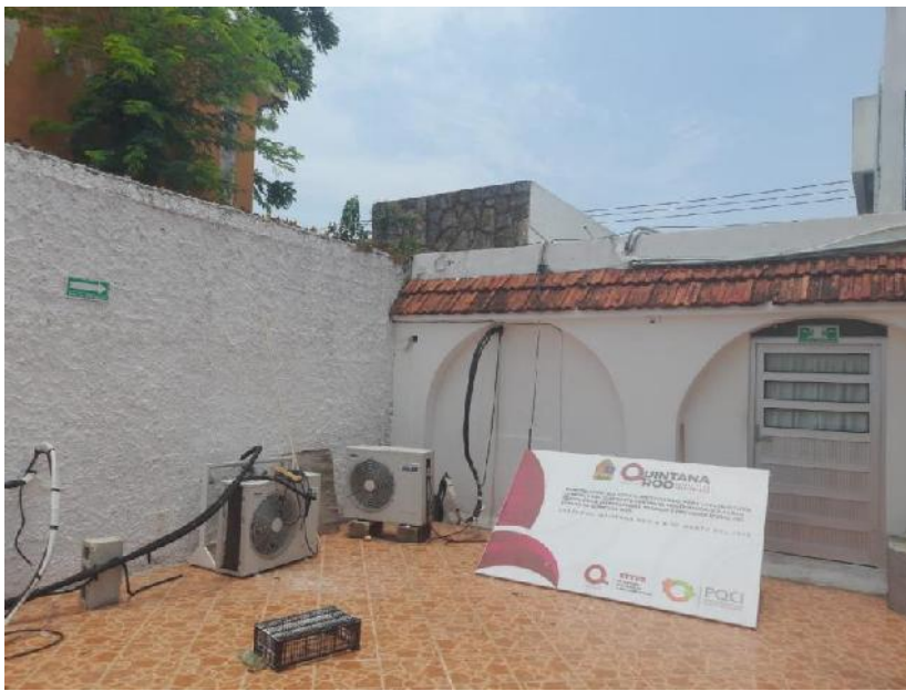
SEÑAL DE RUTA DE EVACUACION Y SALIDA DE EMERGENCIA EN LA PUERTA TRASERA DEL DEPARTAMENTO DE SERVICIOS GENERALES
