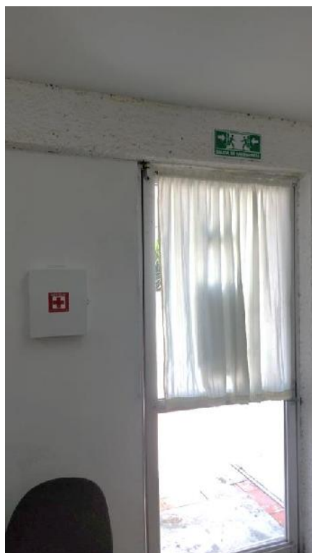
SEÑAL DE SALIDA DE EMERGENCIA Y BOTIQUIN DEL DEPARTAMENTO DE SERVICIOS GENERALES HACIA EL FRENTE DEL EDIFICIO POR LA COCHERA
