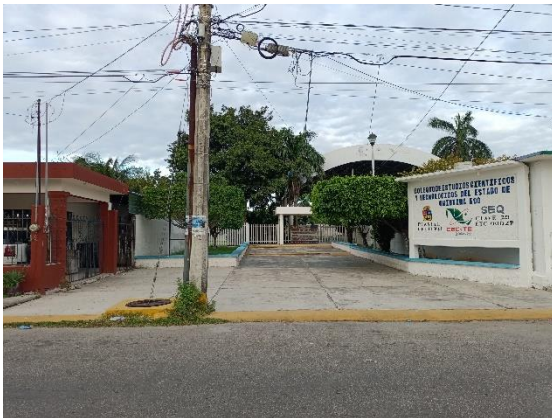
ACCESO POR CALLE TUXTLA GUTIERREZ
