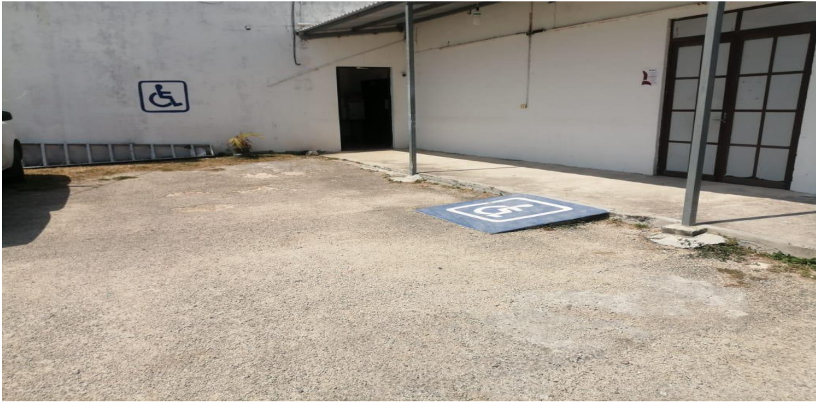
ACCESO TRASERO A OFICINAS: LIBRE DE OBSTÁCULOS.
