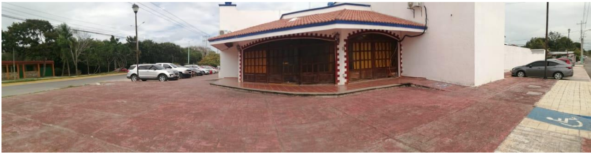
ACCESO 2: ENTRADA PRINCIPAL LIBRE DE OBSTÁCULOS (LADO DERECHO)
