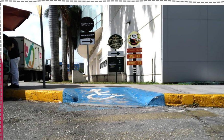
Rampa desde calle
