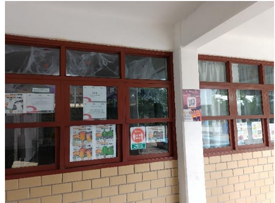
PASILLO POR VENTANILLA DE SERVICIO DE CAJA
