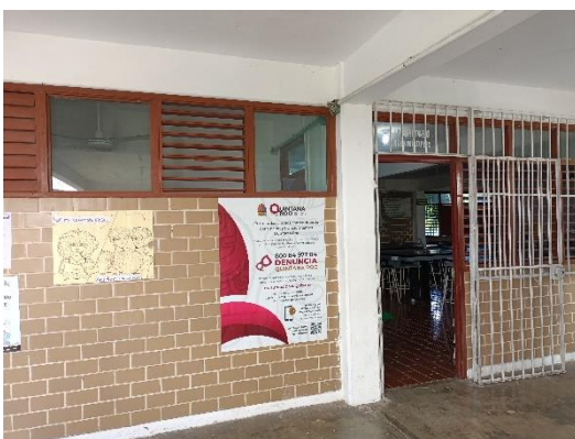
PASILLO DEL EDIFICIO DE SALONES Y LABORATORIOS
