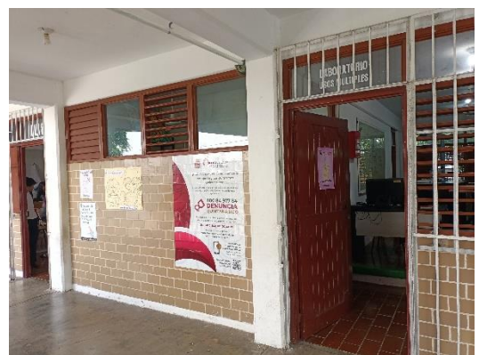
PASILLO DEL EDIFICIO DE SALONES Y LABORATORIOS
