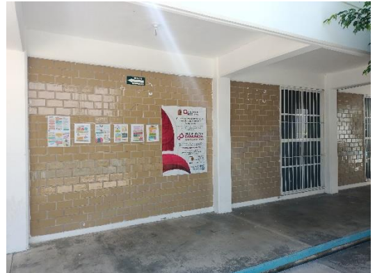
PASILLO DE ACCESO A LA SALA AUDIOVISUAL
