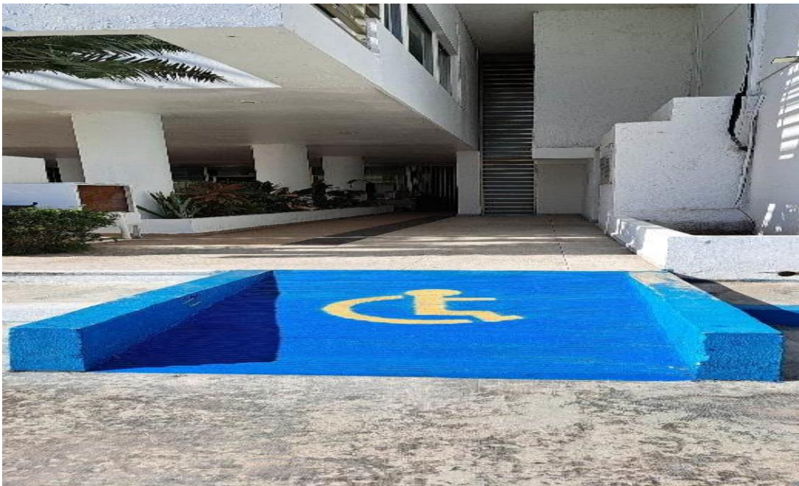
Rampa central a oficinas centrales
