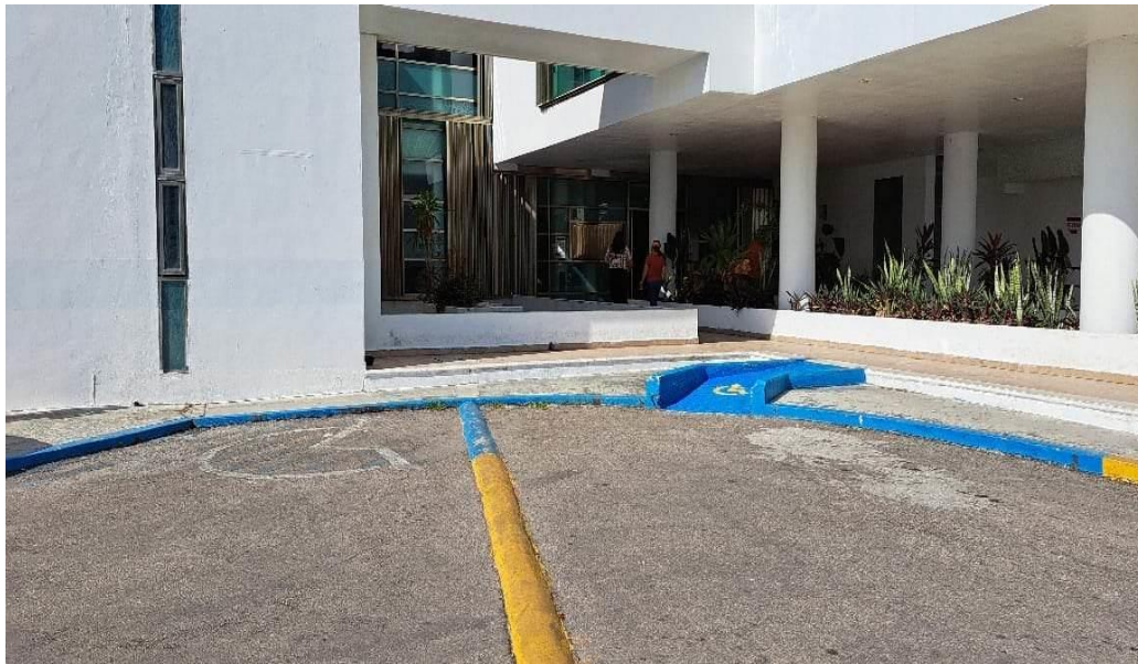
Rampa derecha a oficinas centrales.
