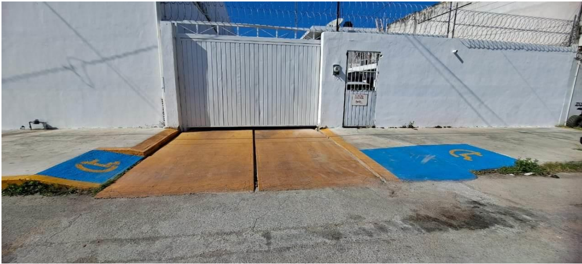
Rampa estacionamiento parte de enfrente
