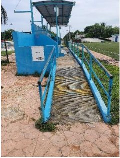
RAMPA PARA DISCAPACITADOS GRADAS DEL CAMPO DE FUTBOL 9
