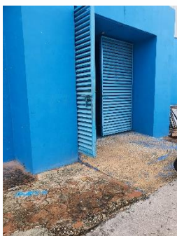
RAMPA PARA DISCAPACITADOS EN LA ENTRADA AL GIMNASIO DE USOS MULTIPLES POR EL AREA DEL ESTACIONAMIENTO
