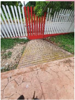
RAMPA PARA DISCAPACITADOS EN LA ENTRADA AL LAS CANCHAS DE TENIS Y CAMPO DE FUTBOL 9
