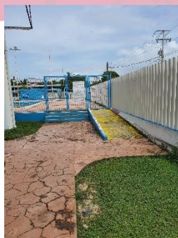
RAMPA PARA DISCAPACITADOS EN LA ENTRADA A LA ALBERCA
