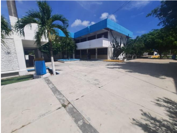
ACCESO A EDIFICIO ADMINISTRATIVO
